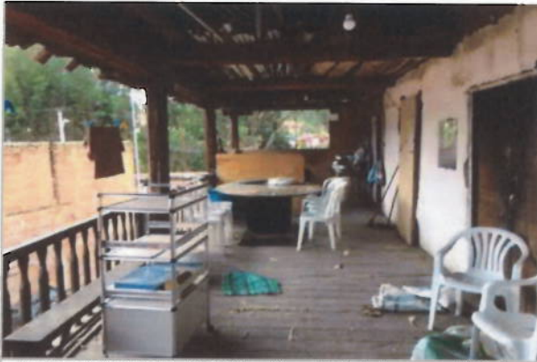
Pasillo exterior planta alta Edificación antigüedad mayor a 100 años
