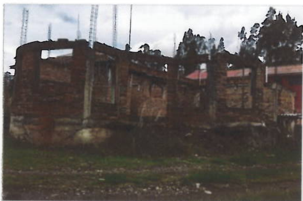
Edificación en proceso de construcción, actualmente abandonada
