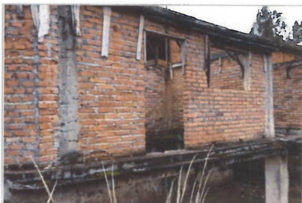
Edificación en proceso de construcción, actualmente abandonada
