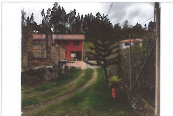
Vista desde acceso hacia las construcciones existentes
