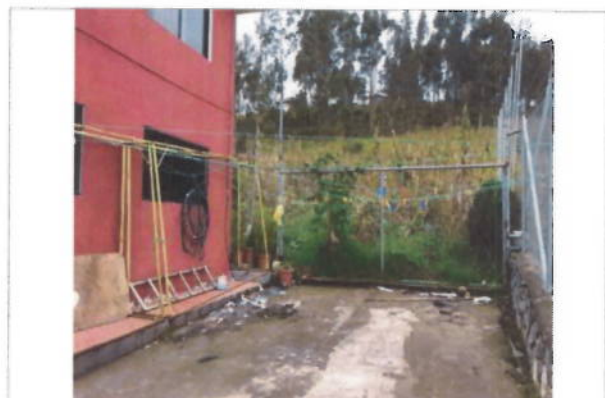
Patio lateral, hormigón simple
