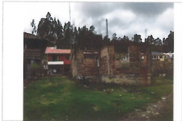
Vista desde acceso hacia las construcciones existentes
