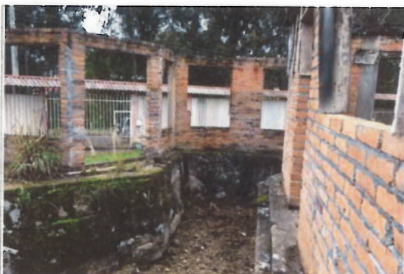
Edificación en proceso de construcción, actualmente abandonada
