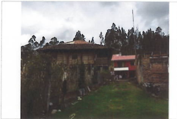
Vista desde acceso hacia las construcciones existentes
