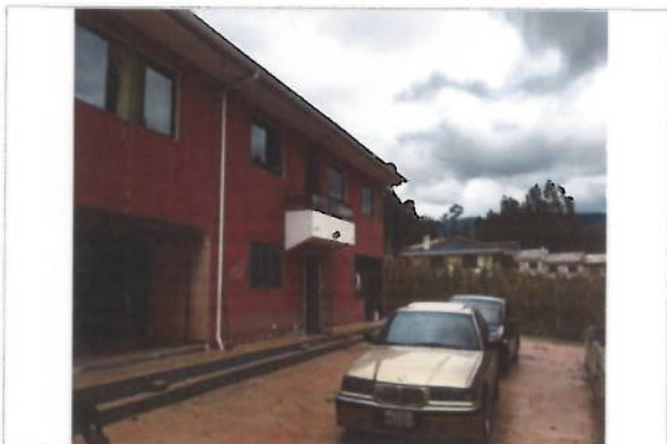
Vista entre vivienda y edificación en proceso de construcción.
