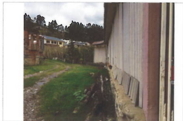
Vista de acceso frontal
