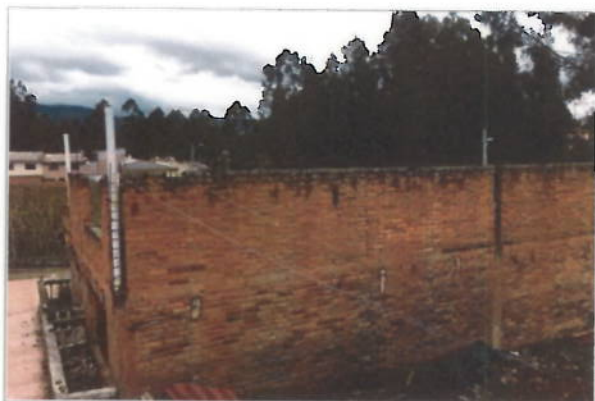
Edificación en proceso de construcción, actualmente abandonada
