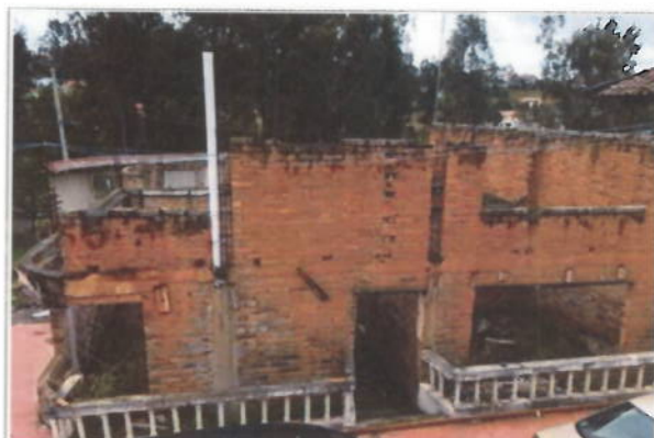
Edificación en proceso de construcción, actualmente abandonada
