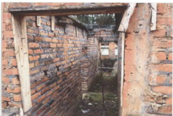
Edificación en proceso de construcción, actualmente abandonada
