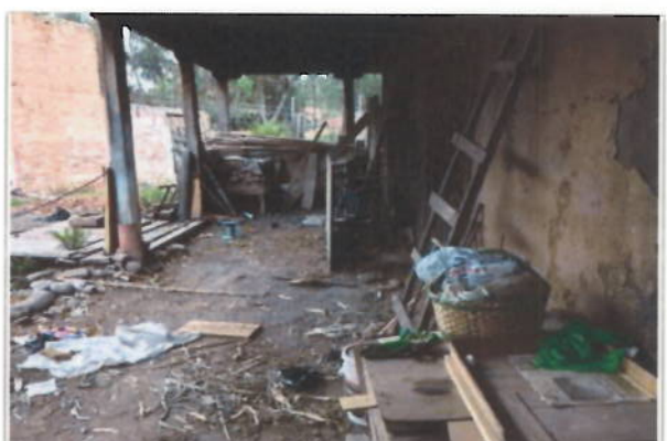
Planta baja pasillos laterales. Edificación antigüedad más de 100 años
