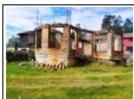
CONSTRUCCIÓN EN ESTRUCTURA
