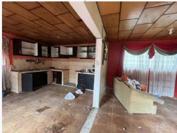
Cocina - P.B - Vivienda de dos pisos
