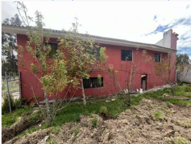
Otro - Vista desde parte posterior de vivienda de dos pisos
