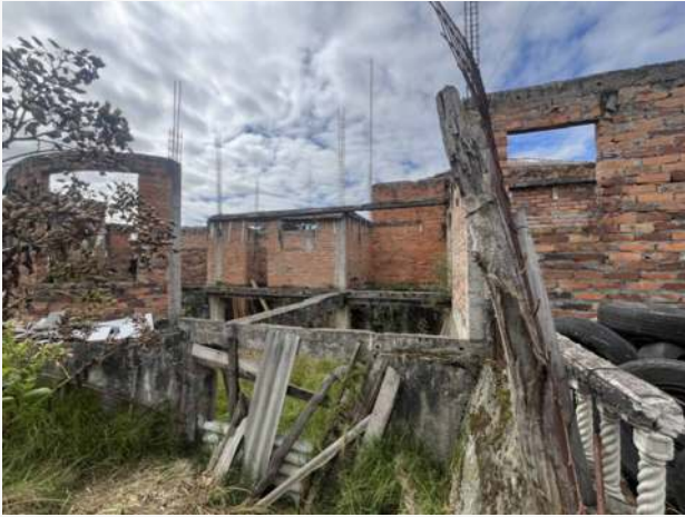
Otro - Construcción en avance de obra (Abandonado - No se valo
