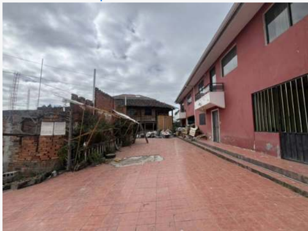
Fachada - Exteriores, patio
