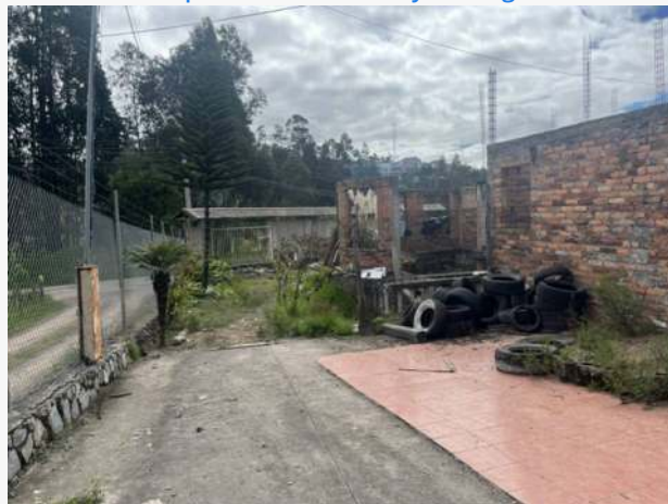
Otro - Exteriores - patios de cerámica y hormigón
