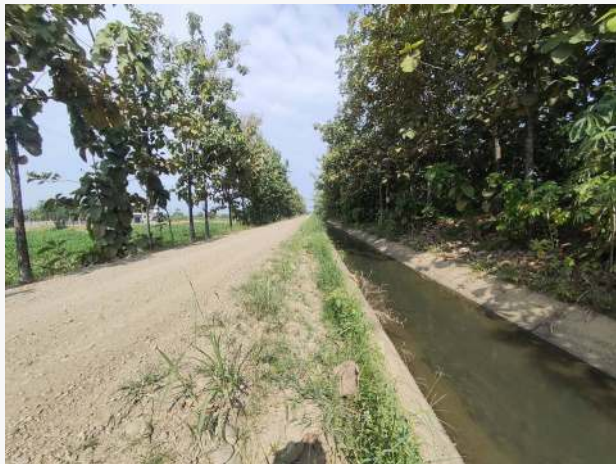
Entorno - Acceso - Vía Estero Blanco
