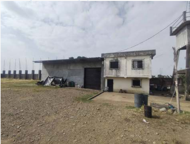
Otro - Vista general - Bodega y vivienda
