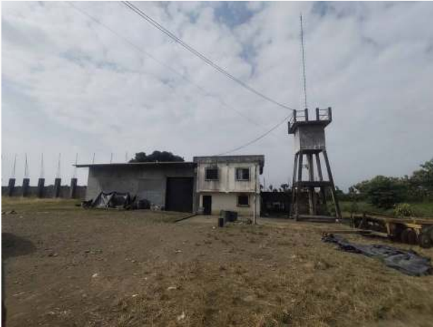
Otro - Vista general - Bodega, vivienda y reservorio
