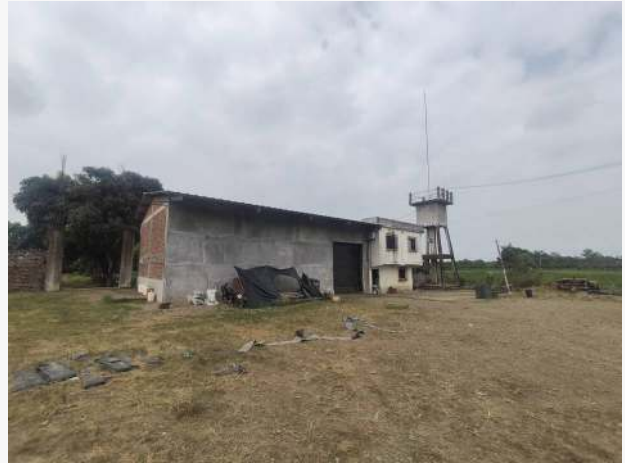
Otro - Vista general - Bodega, vivienda y reservorio
