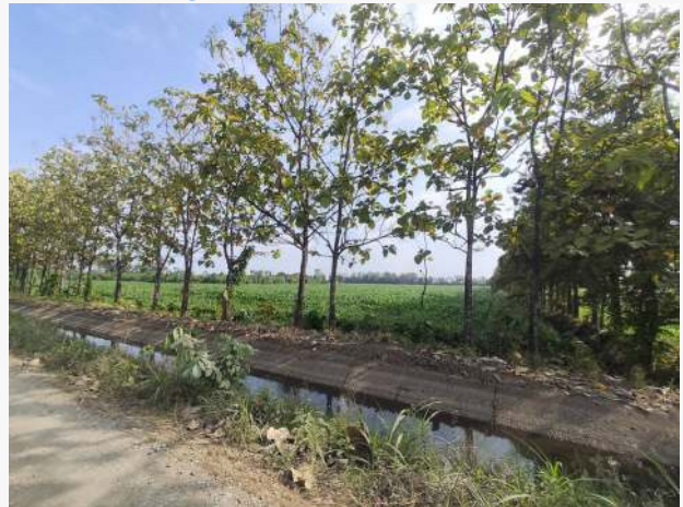
Otro - Canal de riego
