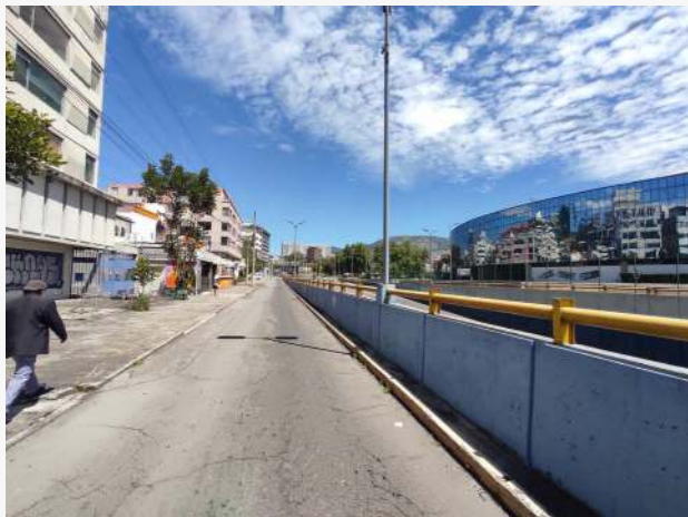
Entorno - Av. 12 de Octubre
